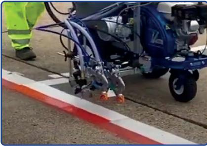
Machine de traçage bi-couleur pour la réalisation de vos travaux, simple ou double bande, de routes, parkings...
